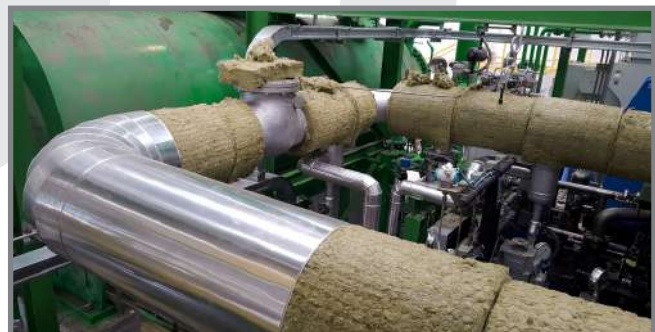
MANTA CON MALLA ROCA BASÁLTICA
