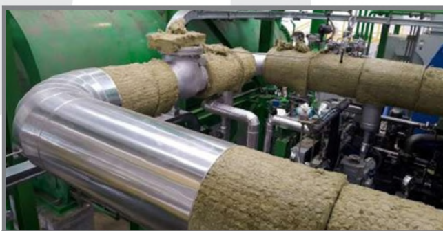
MANTA CON MALLA ROCA BASÁLTICA
