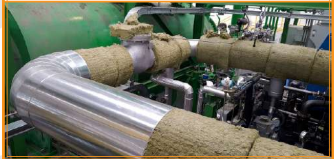
MANTA CON MALLA ROCA BASÁLTICA
