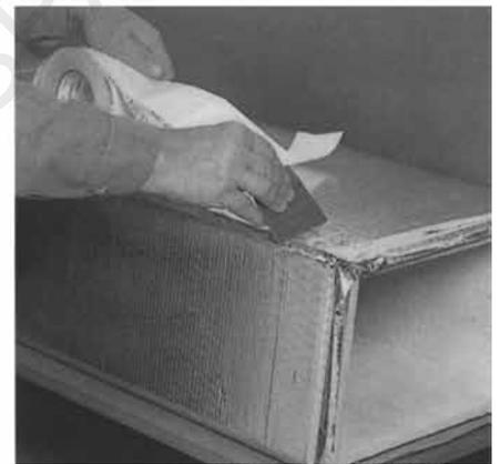
Los ductos Fiberglas® están fabricados con placas rígidas de fibras de vidrio adheridas con resina, con una cara retardadora de vapor hecha de embalaje/hoja de aluminio.
